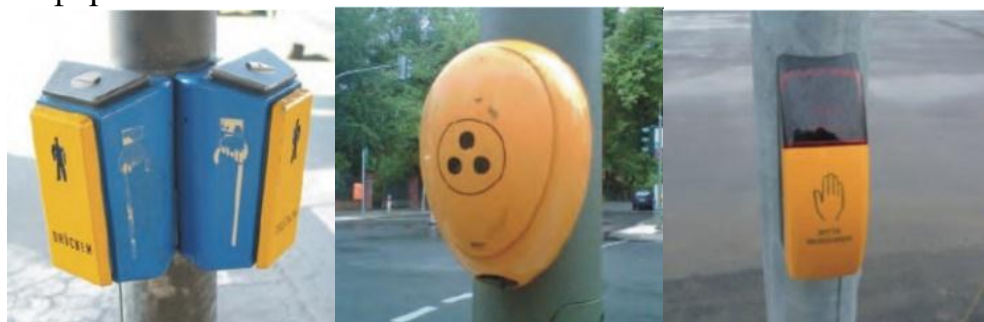
Рисунок 47 – Пример осязательного сигнала пешеходного перехода
