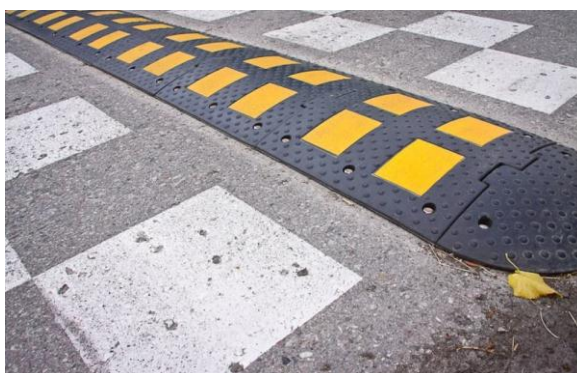
Рисунок 40 – Пример исполнения искусственной неровности сборно-разборной конструкции
