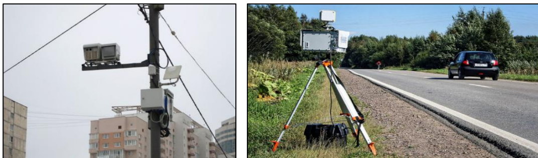
Рисунок 64 – Примеры установки комплексов фотовидеофиксации
