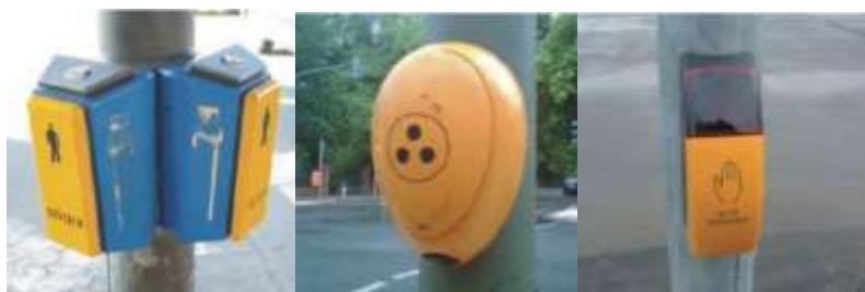
Рисунок 34 – Пример осязательного сигнала пешеходного перехода
